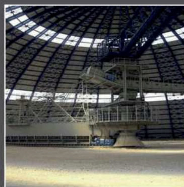
Подвесная система на круглом мостовом реclaimerе, США
