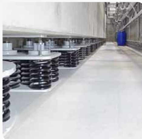
Фундаментный блок с демпферными элементами
